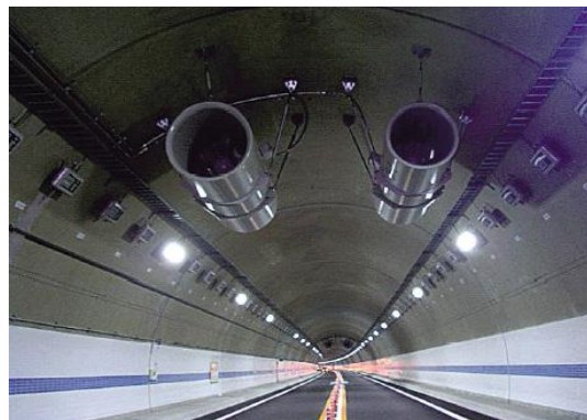
Figur 9 og 10: Langsgående ventilation ved brug af jetfans placeret i nicher og tunnelloft.
