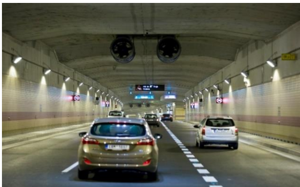
Figur 9 og 10: Langsgående ventilation ved brug af jetfans placeret i nicher og tunnelloft.
