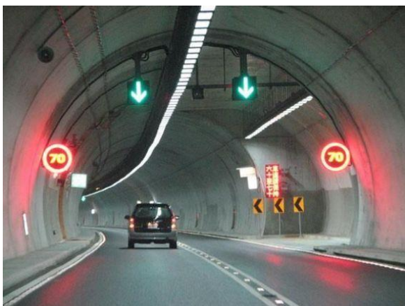
Figur 11: M&E og ITS i moderne vejttunnel.
